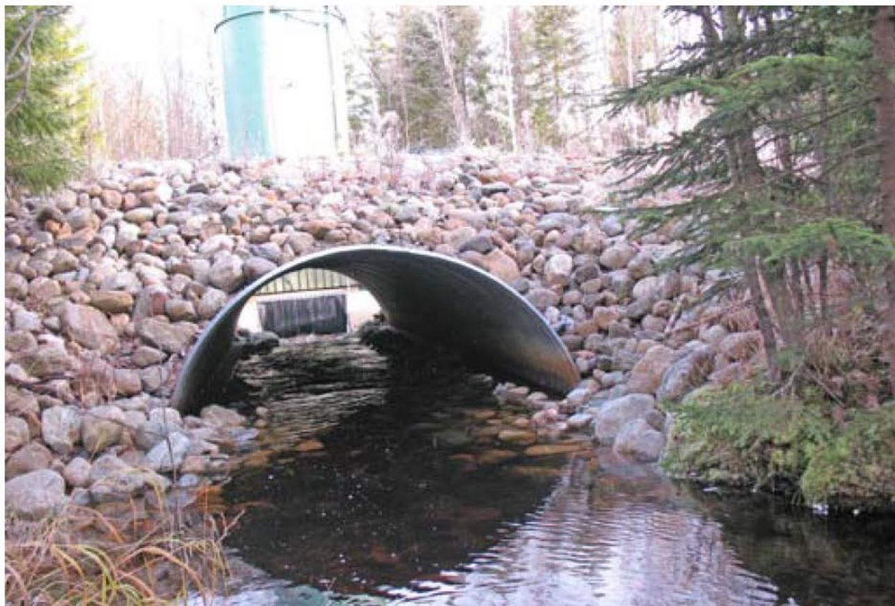
*Bild 1. Trumman ovan doseraren kördes sönder av en bulkbil och ersattes under 2000 med en halvtrumma av galva.*
